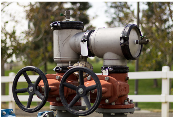
Dispositif antirefoulement à pression réduite 475ST en acier inoxydable installé pour protéger contre le siphonnement à rebours et la contrepression dans les applications à fort potentiel de danger.
